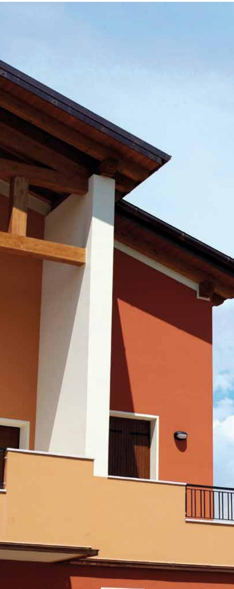
Primjena obloga s kvarcom na fasadama stvara učinkovitu nepropusnu barijeru za atmosferske zagađivače, elastičnu i otpornu na površinsku lužnatost. Estetski izgleda ugodno i homogeno zahvaljujući izvrsnoj moći zapunjavanja i ujednačavanja nepravilnosti.
